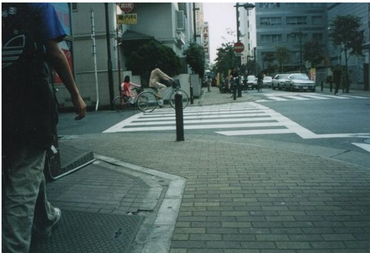
写真 3 歩道の真ん中に立つ車止め
