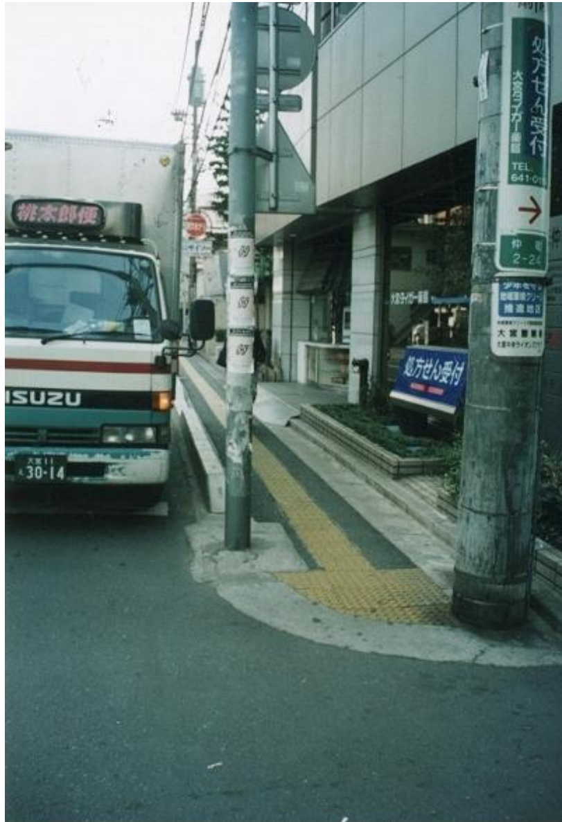
写真 5 狭い歩道上に立つ電柱
