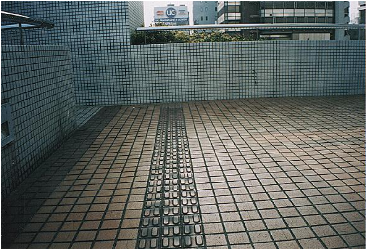
写真 1 壁へ直進する点字ブロック
