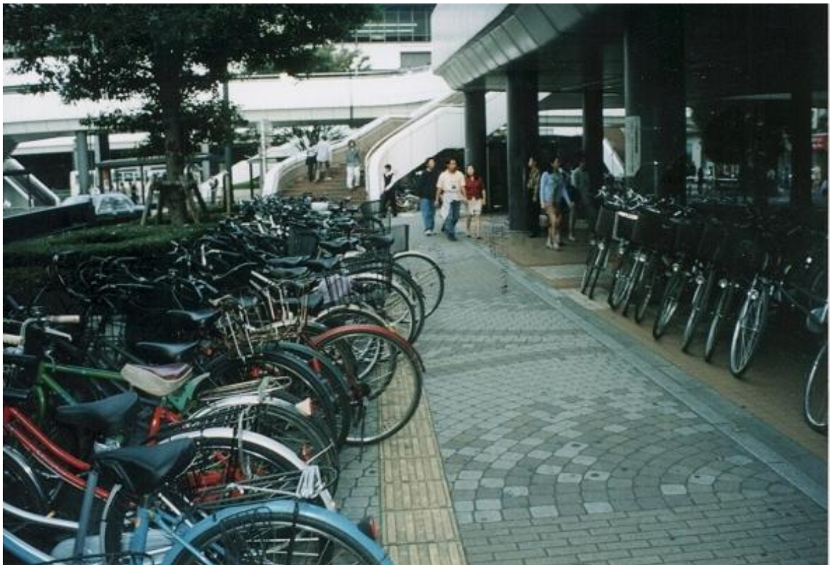
写真 8 点字ブロックを隠している放置自転車
